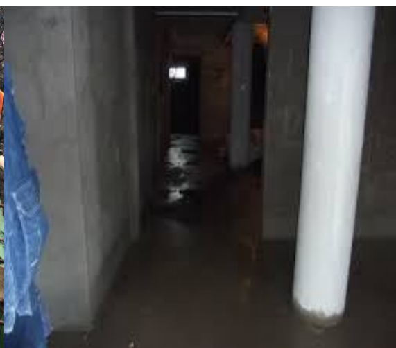
Figura4. Infiltrații
