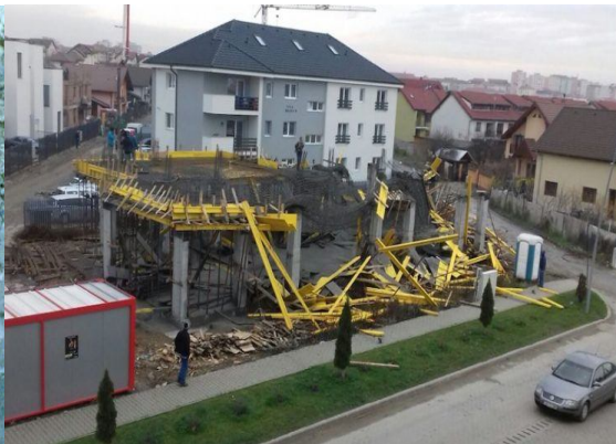
Figura2. Destrămare cofraj
