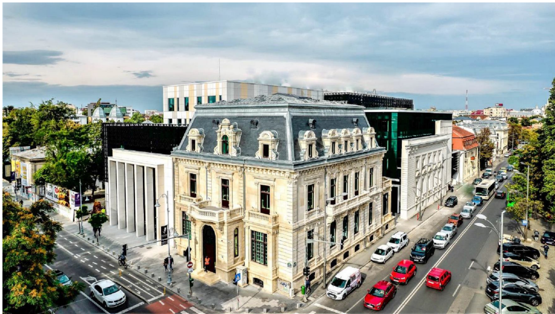
Figura 2.2. „Casa Cesianu” – vedere de ansamblu
