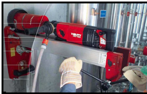
Figura 1. Exemplu de extragere a unei carote din betonul armat 8
