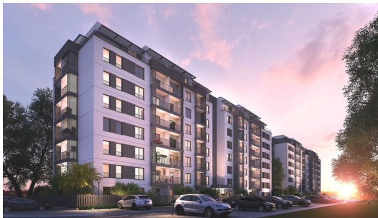
Fig 2.- Complex rezidențial H Pipera Lake - lucrări de referință-S.C. PMA CONSTRUCT S.R.L
