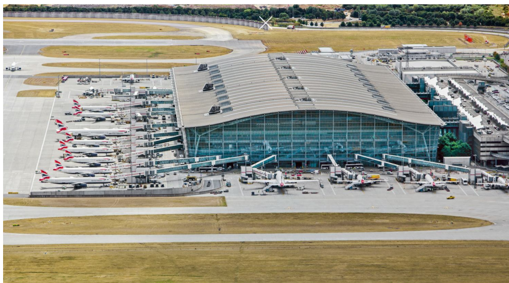
Figura 2. Terminalul T5 finalizat și pus în funcțiune
