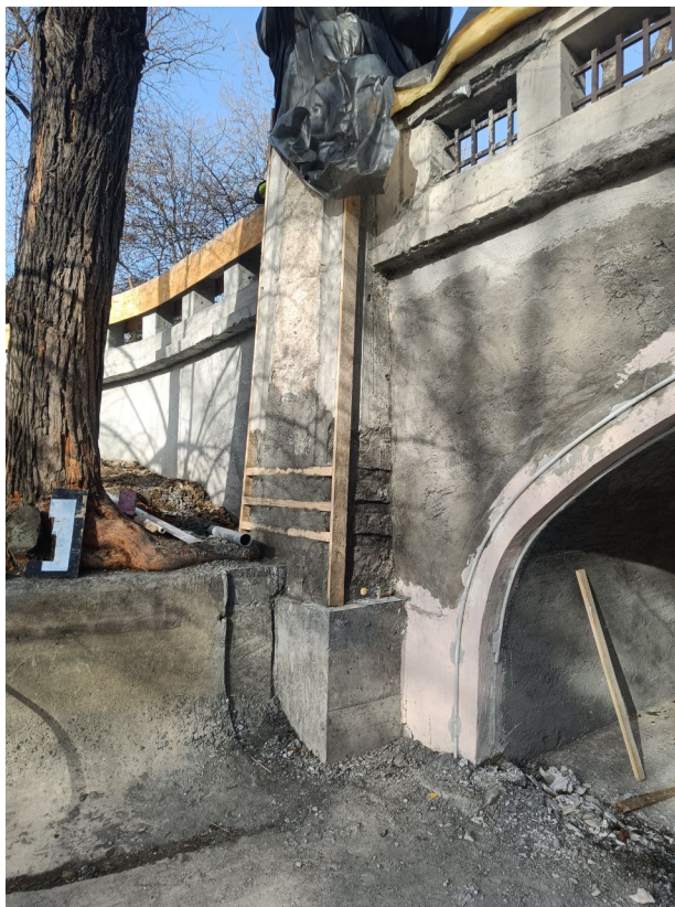
Figura 4.6. Detaliu în urma consolidărilor fundațiilor stâlpilor de la nașteri
