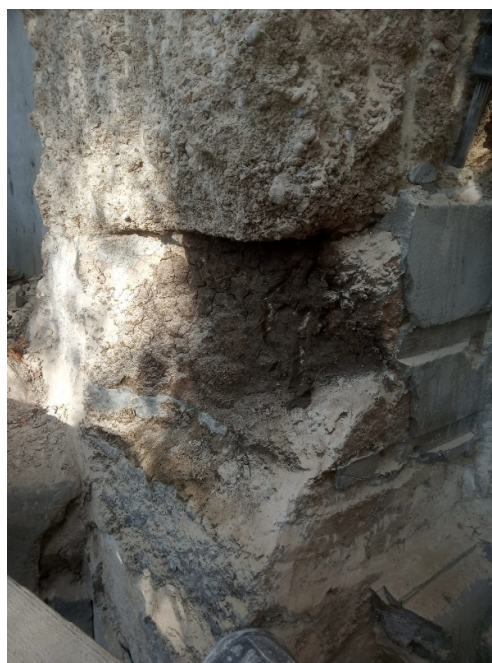
Figura 4.5. Detaliu stâlp dinspre aleea Magnoliei în urma demolării materialelor degradate
