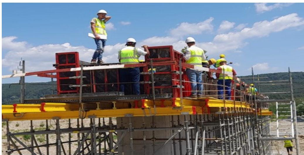
Figura 13 Realizarea balustrăzilor din materialele prezente la punctul de lucru
