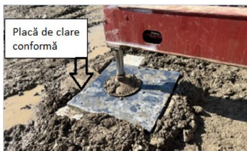
Figura 7 Placă de calare conformă
