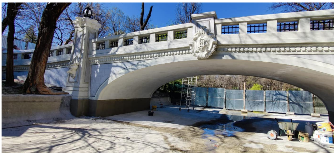
Figura 6. Vedere de pe latura sudica, dupa restaurare, postata de primarul orasului, Nicușor Dan
