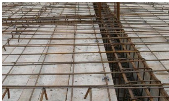
Figura 5 – Lipsă armare superioară planșeu
