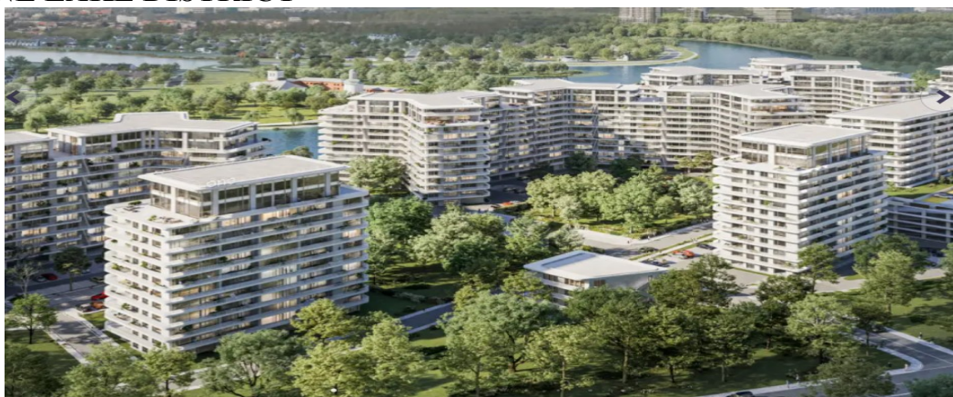
Fig 3. – Complex Rezidențial One Lake District– Lucrări de referință – One United Properties
