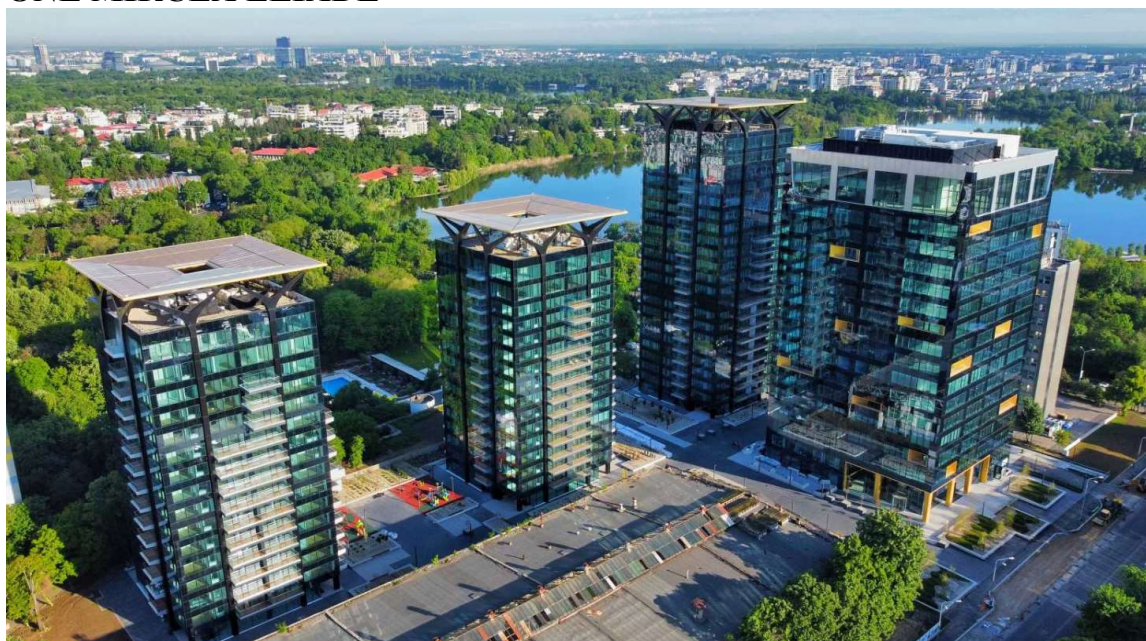
Fig 1. – Complex Multifuncțional One Mircea Eliade – Lucrări de referință – One United Properties
